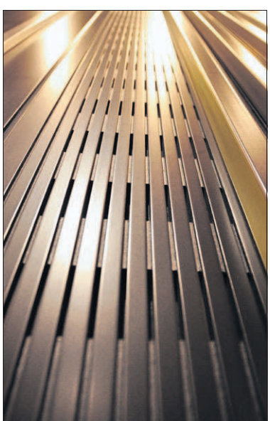
Die perforierten Wände aus der Nähe. Der Saal wurde auf eine mittlere Nachhallzeit eingestellt, damit ist er für unterschiedliche Zwecke geeignet. Foto: luke
